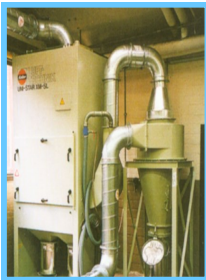
Zyklonvorabscheider
