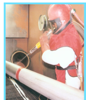
Reinigen von Stahlrohren durch Sandstrahlarbeiten.
