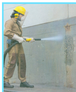
Reinigen von Gebäudefassaden.
