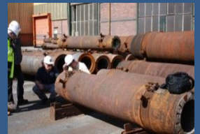
Beseitigung von Korrosionen.
